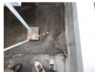
■屋根（防水層）の状況
