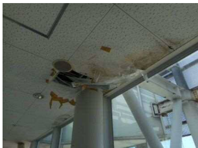
■室内（天井）の状況
