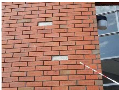
■外壁（レンガ張り）の状況
