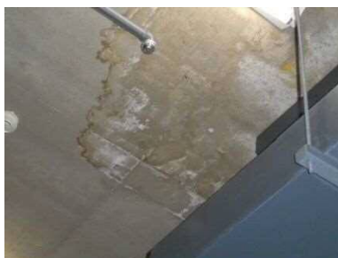
■室内（天井）の状況
