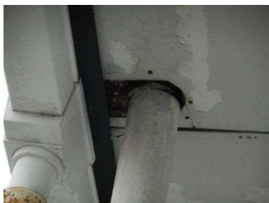
■雨樋（軒裏）の状況
